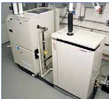
5. ábra. Háztartási tüzelőanyag-cellás kombinált villamos-és hőenergia ellátó egység
