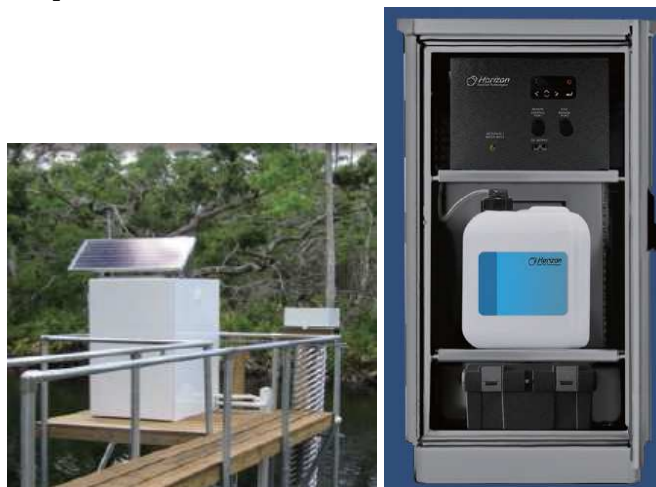
Napelemmel kombinált tüzelőanyag-cellás rendszer teljes felépítménye (balra), és maga a tüzelőanyag-cella (jobbra felül) valamint a „külső” üzemanyagként szolgáló metanoltartály (jobbra középen). Kép: horizonfuelcell.com
