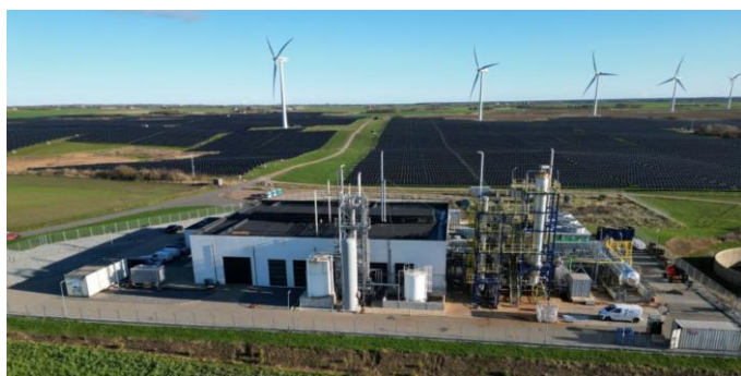
A világ első, dinamikus zöld ammónia pilot üzeme a dániai Rønde-ben. Kapacitása ~5.000 tNH 3 /év; a működés megkezdése: 2025. Partnerek: Topsoe, Skovgaard Energy, Vestas. Kép: Topsoe.
